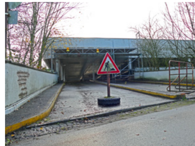
2017 – Zustand der Alten Polizeischule an der Norbertstraße
