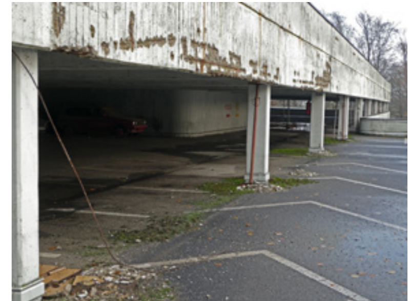
Immense Kosten – Sanierung der Liegenschaft
