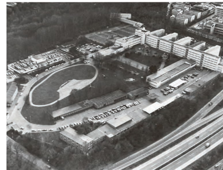
Liegenschaft „Alte Polizeischule“ an der Norbertstraße
